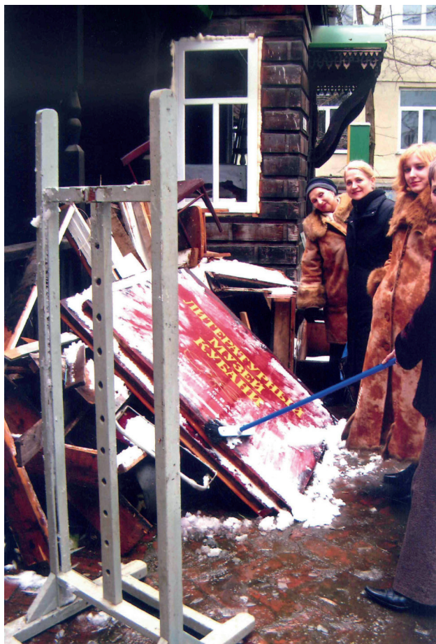
Перед закрытием Литературного музея на капитальный ремонт, 28.12.2006 г.
