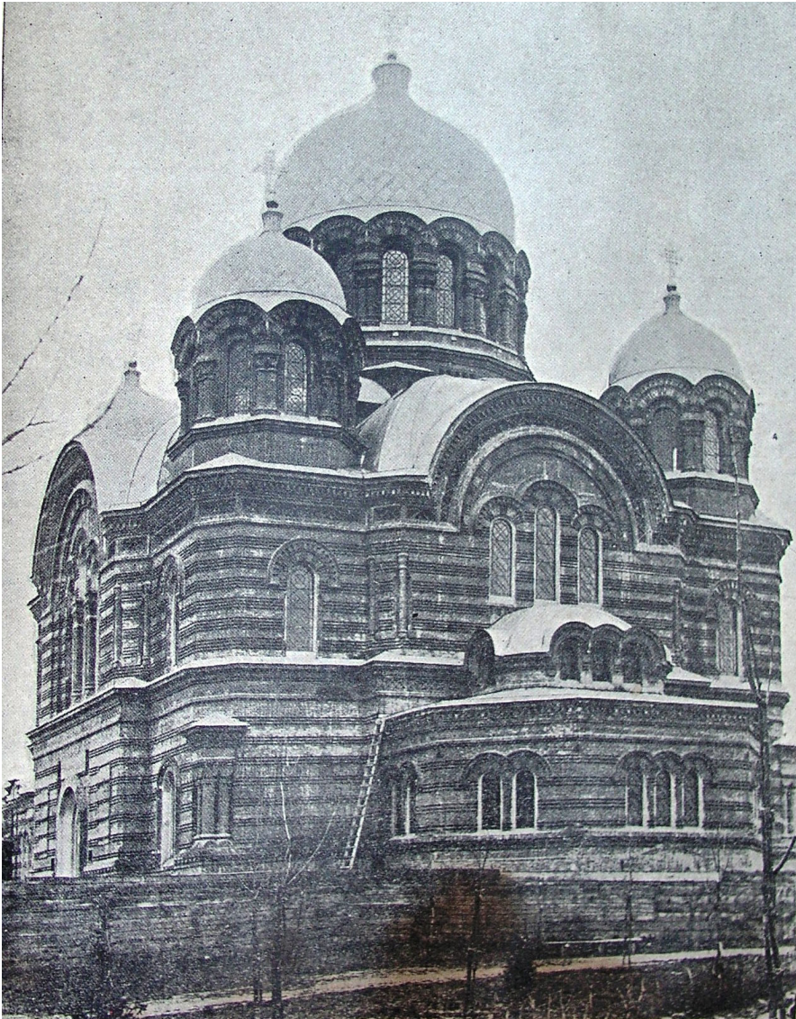
Строящийся Екатерининский собор. Южный и восточный фасады. Фото 1912 г. [10, с. 85]
