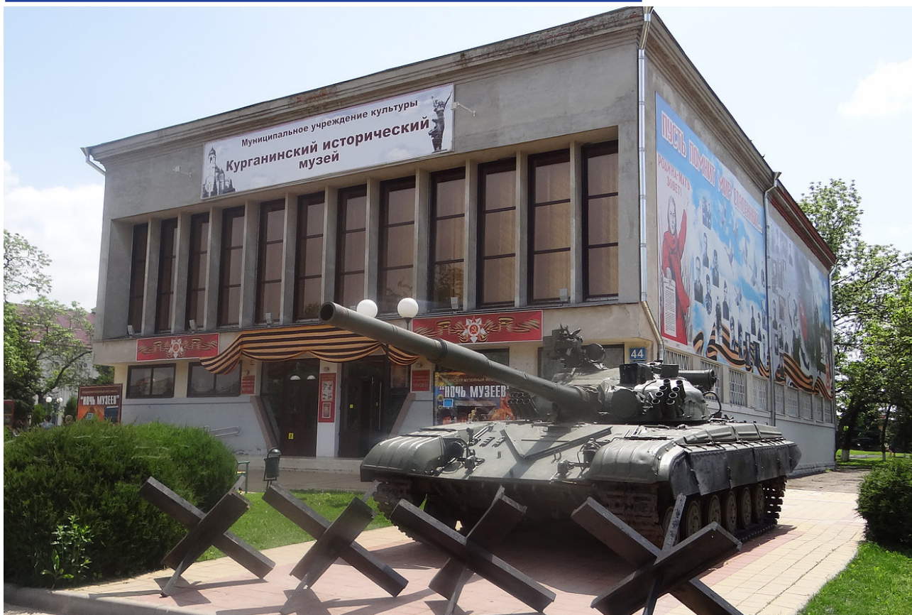
Рис. 2. Здание Курганинского исторического музея (современный вид) [7]
