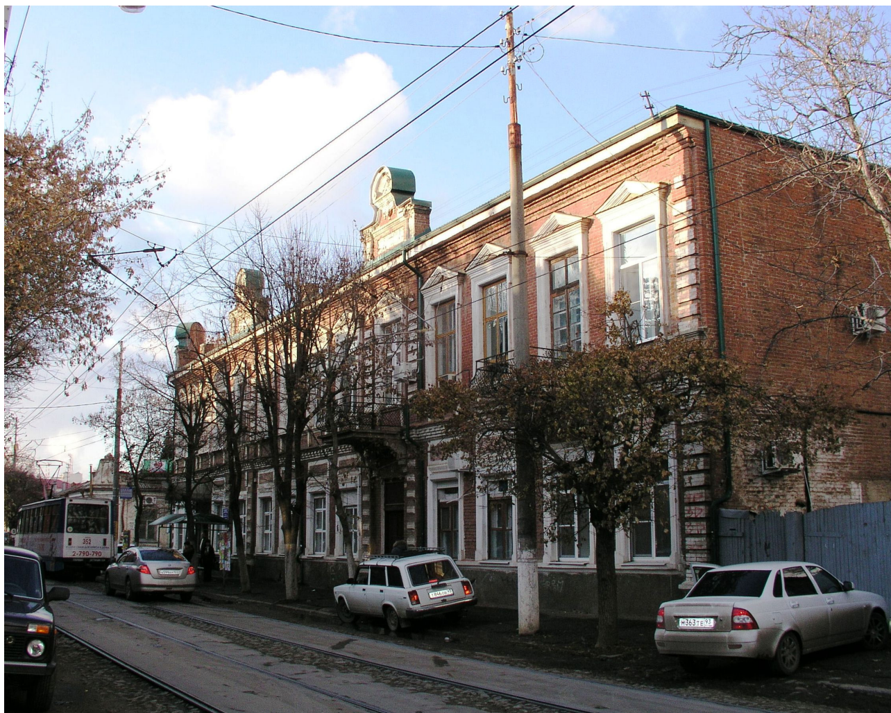
Вид на южный фасад с улицы им. Гоголя. Фото В. Бондаря. Январь 2013 г.
