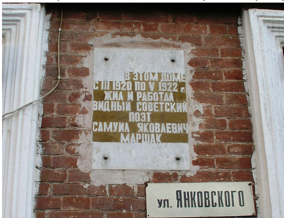
Памятная доска на западном фасаде. Фото В. Бондаря. Январь 2013 г.
