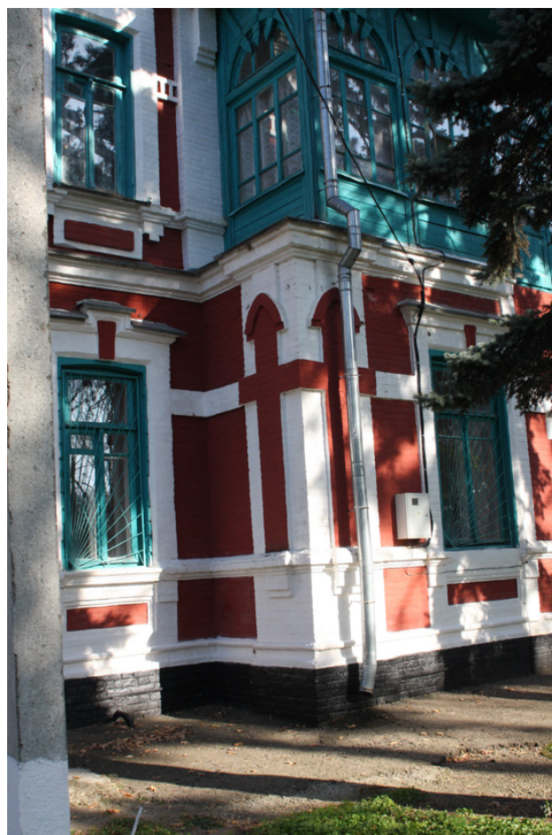
Кирпичная узорная кладка в форме крестов на фасаде молельной комнаты усадебного дома
