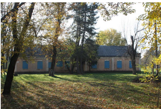
Дом для рабочих (помещик Щербак провел в этот «барак» воду, тепло и свет)
